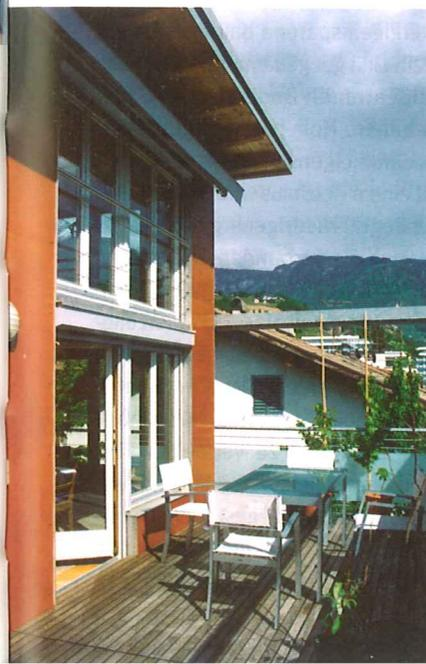
*Dieses Bild zeigt den selben Holzbau. Der Terrassenboden besteht aus einem Holzlattenrost. Darunter befindet sich ein gedämmter und wasserdicht isolierter Flachdachaufbau. Die Holzständerkonstruktion ist außen mit einer wasserfesten aber hinterlüfteten Holzfassadenplatte verkleidet.*
