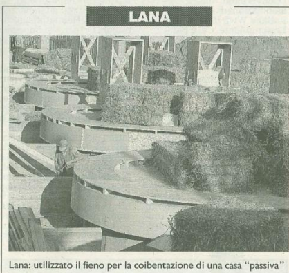
Lana: utilizzato il fieno per la coibentazione di una casa "passiva"
