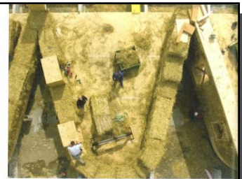
Ein Hof voller Strohballen: In nur vier Monaten Bauzeit standen die neuen Wohnungen mit ihren dicken Wänden aus gepressten Strohballen.
