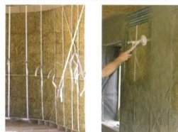
Il muro in paglia con i tenditori in polietilene, poi intonacati con argilla
