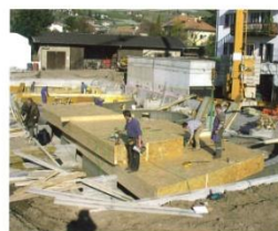
Pila dei solai in legno riempiti di paglia
